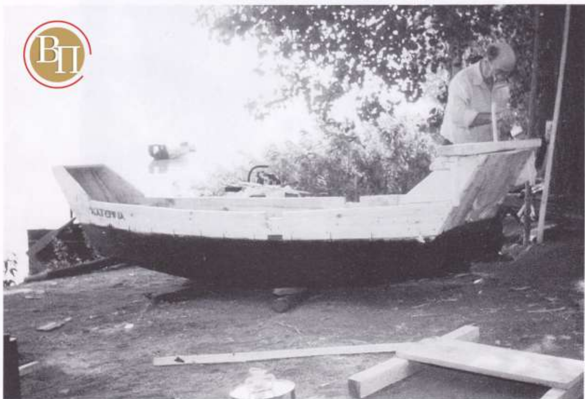
Το τροχαντήρι έτοιμο για τοποθέτηση.
