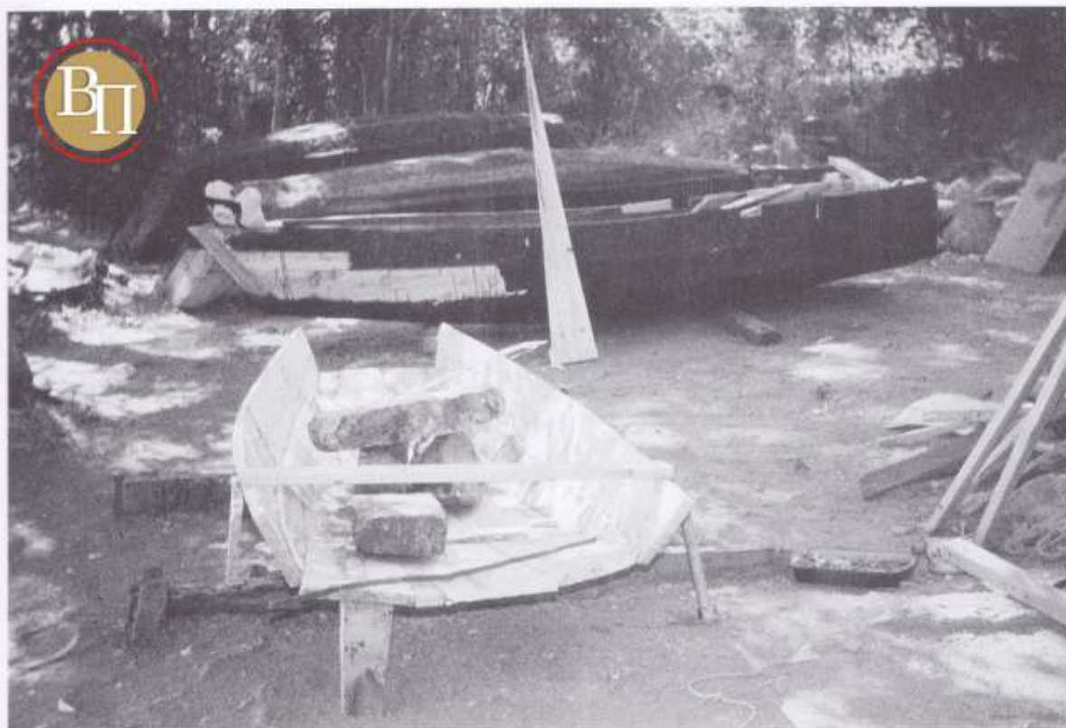
Τα δυο πλευρά, η βάση της κατασκευής του καραβιού. Πλευρά, σφήνες και πάτος έχουν δώσει μορφή στο καράβι.
