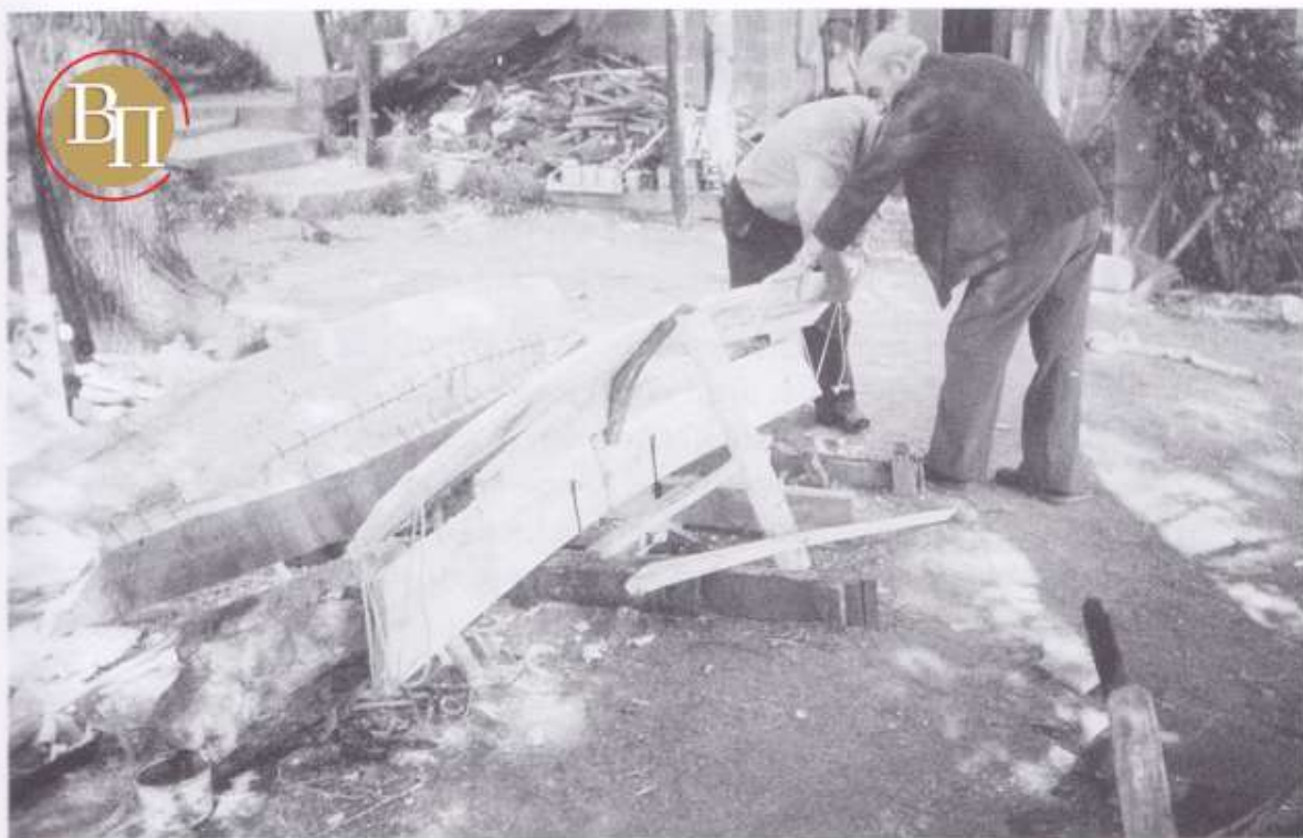
Τα δυο πλευρά, η βάση της κατασκευής του καραβιού. Πλευρά, σφήνες και πάτος έχουν δώσει μορφή στο καράβι.
